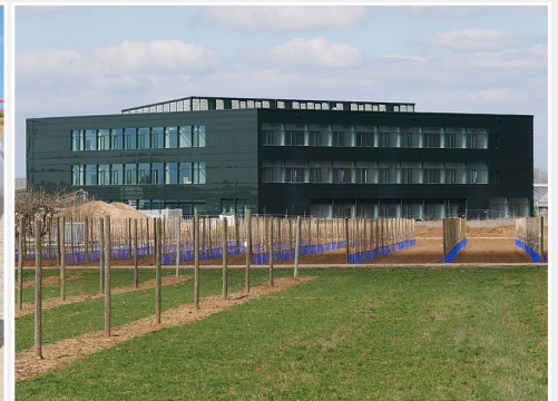
Neues Institutsgebäude in Dossenheim New Institute's building in Dossenheim (© Jelkmann/JKI)
